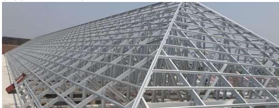
Gambar 7. Rangka Atap Baja Ringan [30].
