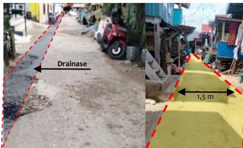
Gambar 2 Kondisi Jalan & Drainase Permukiman [14]
